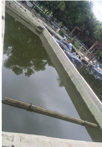
Gambar 4.18. Kolam Sedimentasi Sumber: Dokumentasi Penulis
