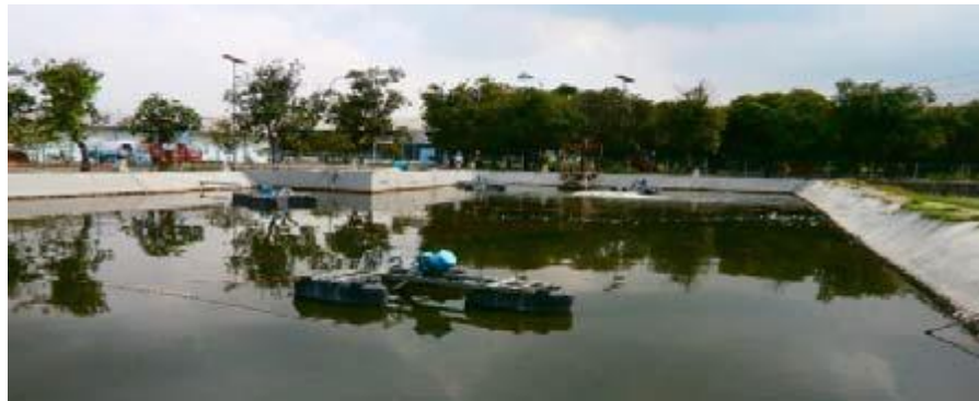
Gambar 4.17. Kolam Aerasi Sumber: Dokumentasi Penulis
