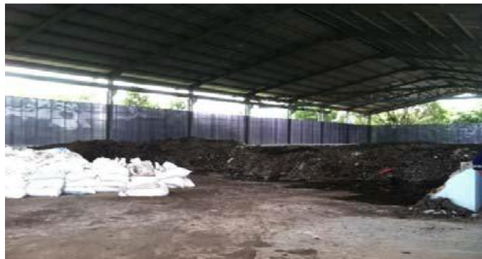
Gambar 4.16. Sludge Drying Bed Sumber: Dokumentasi Penulis
