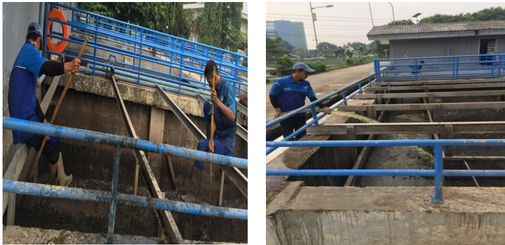
Gambar 4.3. Screen/ Saringan IPLT Konvensional Sumber: Dokumentasi Penulis
