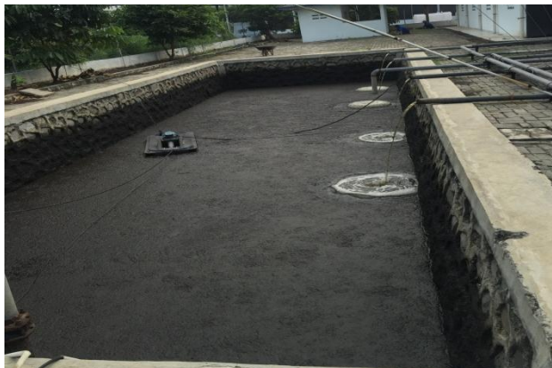
Gambar 4.15. Break Tank Sumber: Dokumentasi Penulis
