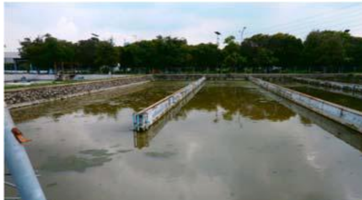
Gambar 4.8. Kolam Maturasi Sumber: Dokumentasi Penulis
