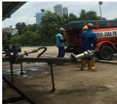
Gambar 4.12. Penerimaan lumpur tinja ke mesin SAP Sumber: Dokumentasi Penulis
