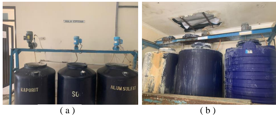
Gambar 5.7 Unit Desinfeksi (a) Tangki Input Bahan Kimia (b) Tangki Mixer
