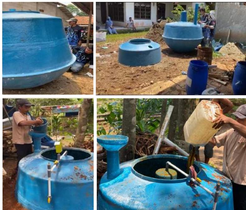
Gambar 4.4. Kegiatan Instalasi Biodigester
