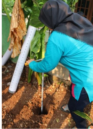
Gambar 5.2. Proses Pembuatan Biopori
